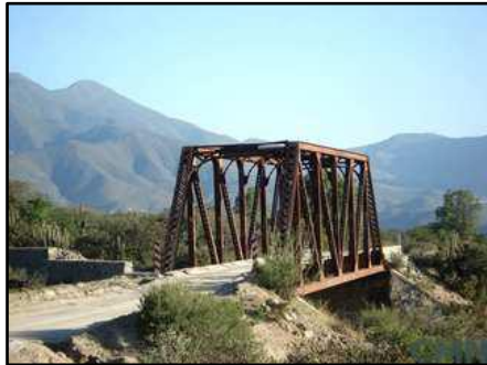
Puente Metálico el Ojo
